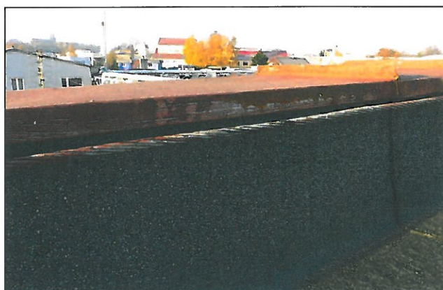
Oplechování říms a atik doléhá těsně.
